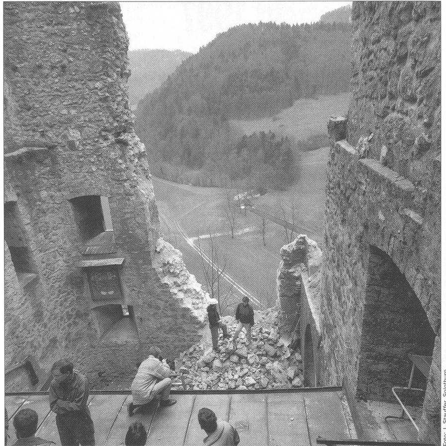
Abb. 3 Das Innere des ehemaligen Wohnturms nach dem Teileinsturz.
