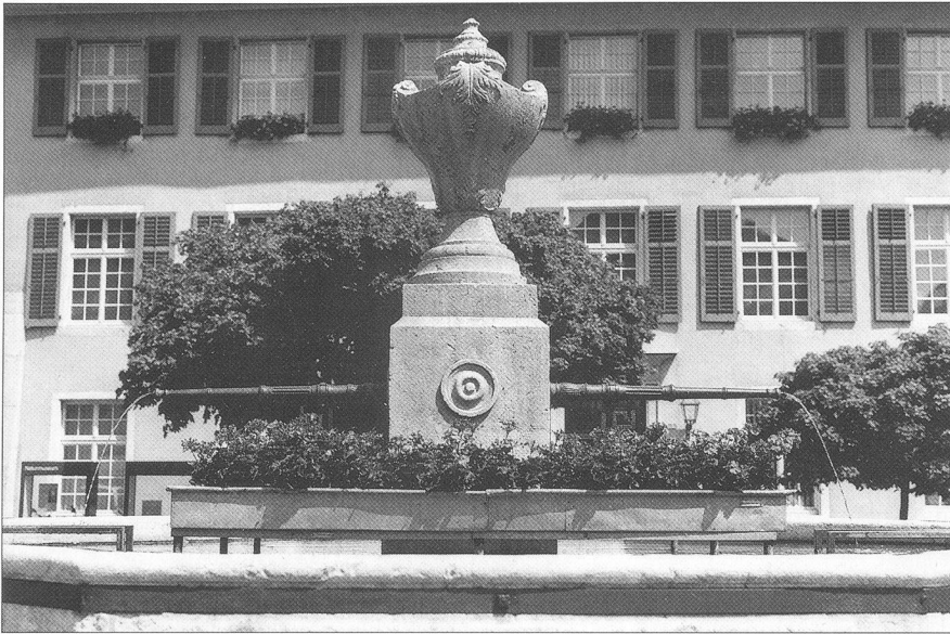
Abb. 3 Der Stock mit den beiden Wasserröhren und dem Vasenaufsatz, nach der Restaurierung von 1997.
