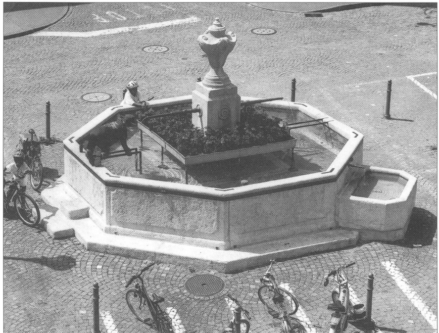
Abb. 1 Solothurn, Brunnen am Klosterplatz, nach der Restaurierung von 1997.
