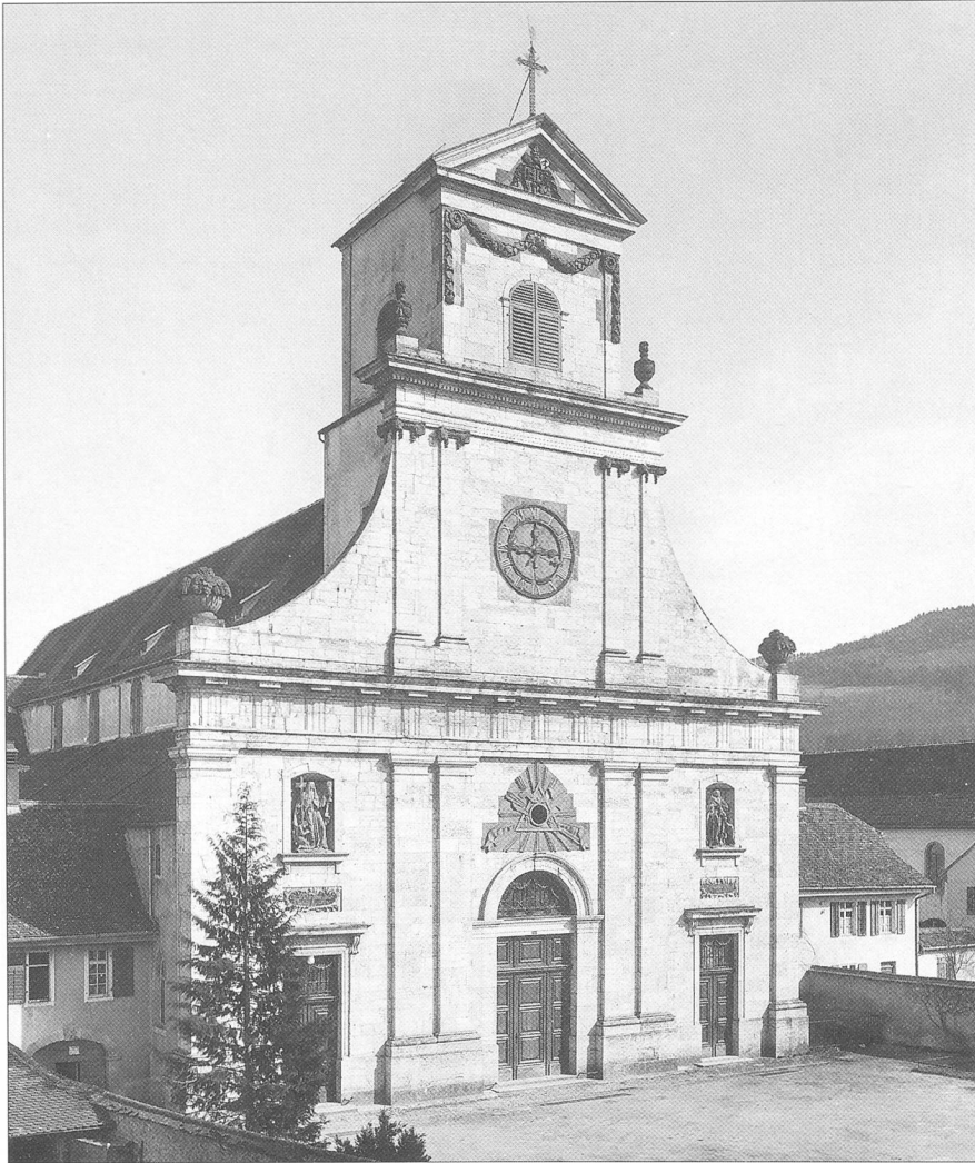
Abb. 2 Fassade vor der Restaurierung von 1972/73. Die roten Sandsteinquader sind ungefasst und heben sich deutlich vom hellen Inzinger Stein ab.
