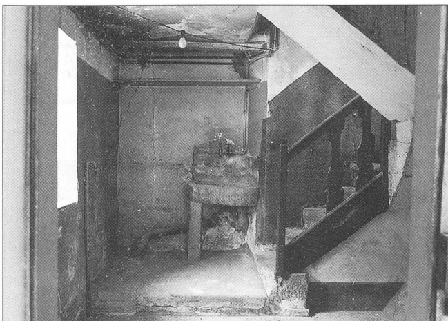
Abb. 8 Küche im ersten Obergeschoss, vor dem Umbau.
