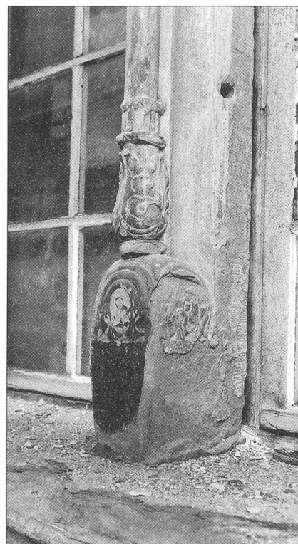
Abb. 4 Detail des Staffelfensters im zweiten Obergeschoss vor ...
