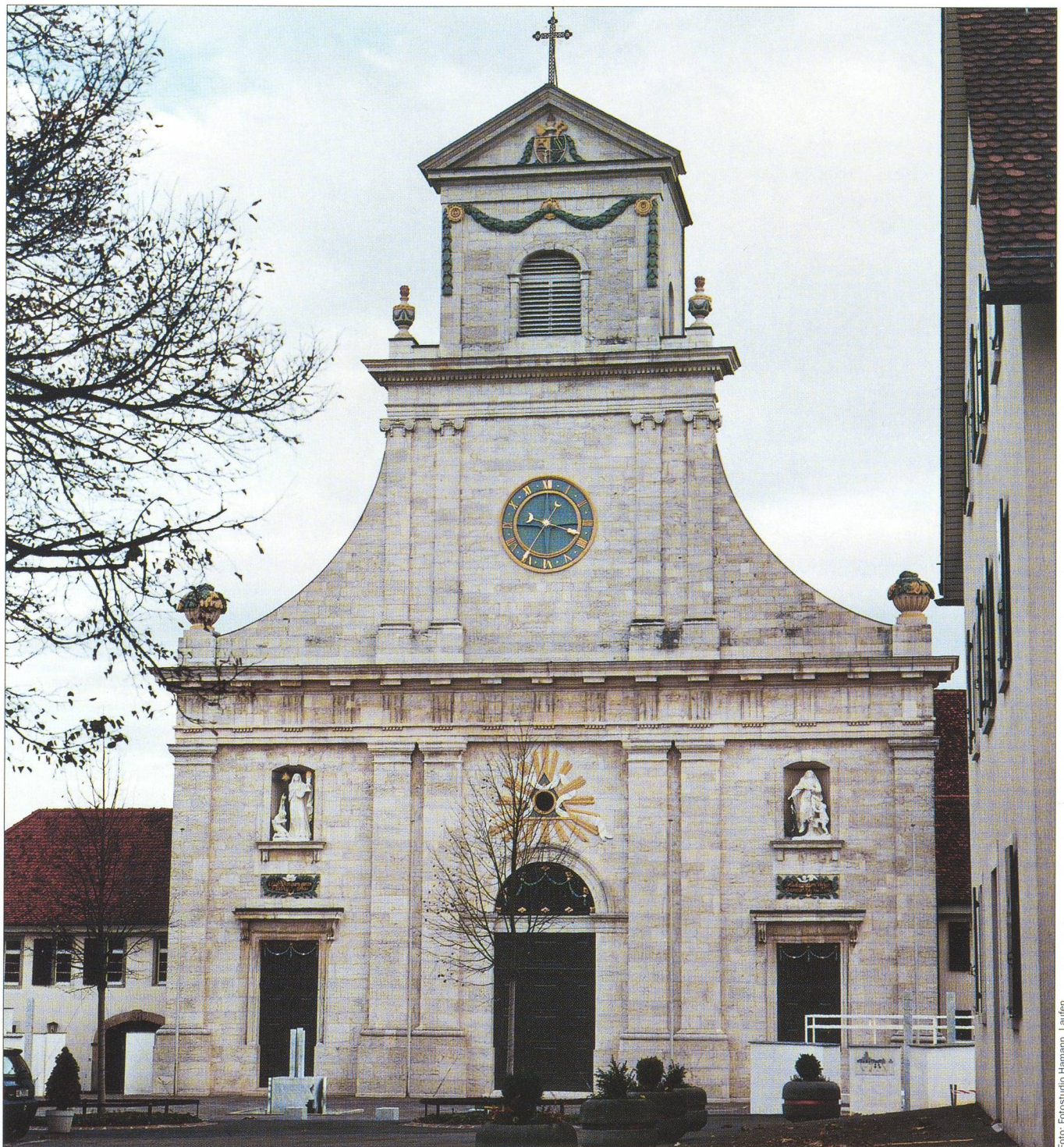
Abb. 3 Fassade nach der Restaurierung von 1997.
