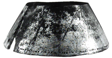
Abb. 23 Zuoberst auf dem Turmhelm, dort wo der Spiess mit dem Windzeiger aus der grossen Kugel hinausläuft, musste 1623 diese «Chappe» zur Abdichtung angebracht werden. Die Umschrift lautet: «ANO DOMINI 1623 WARD M.IOHAN OKO WAGNER SCHULDHEIS H.ALTERNRAT BENEDIKT STRODEL H.URS VON ARX (BUWHERR) NICOLAUS DODINGER ZÜGWART M.WERLI DÜRG DIE HABEN AN GMACH DER ZIT VERGULT M.URBAN KÄRLER URENRICHTER.»
