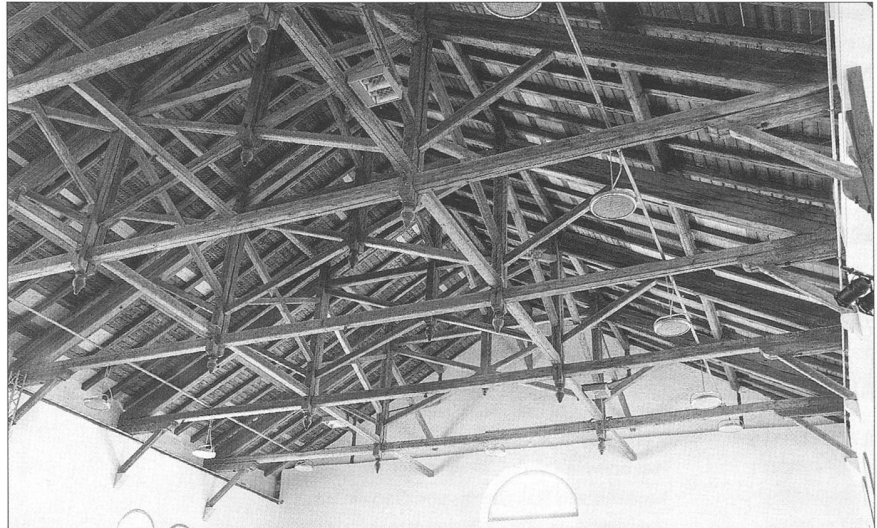
Abb. 6 Blick in die imposante hängende Dachkonstruktion von 1863, Zustand 2002.
