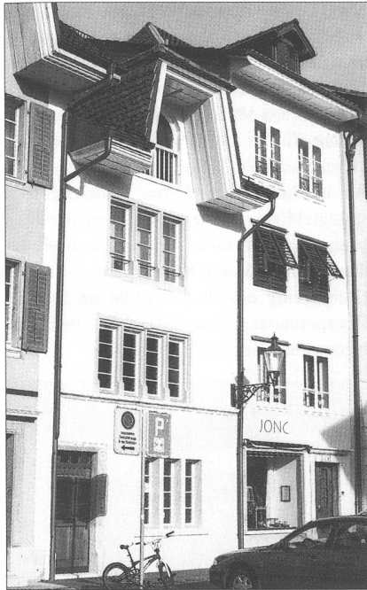
Abb. 2 Fassade nach der Renovation. Die rekonstruktive Rückführung in einen älteren Zustand ist nur beim Fenster im ersten Obergeschoss wirklich gegückt.
