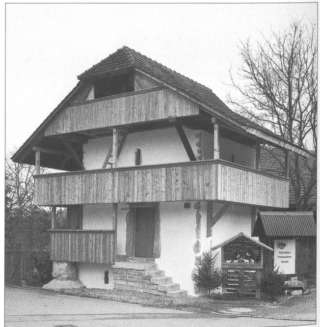
Abb. 3 ... und nach der Restaurierung mit rekonstruierter Laube, im Dezember 2000.
