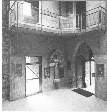
Abb. 6 Eingangspartie mit neuer, doppel-schaliger Südwestecke aus Beton. Zwischen den Betonmauern befindet sich der neue Aufgang zu den Galerien und auf das Dach.
