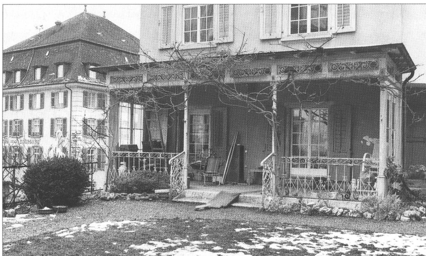
Abb. 3 Die Veranda, vor der Restaurierung, 1998.
