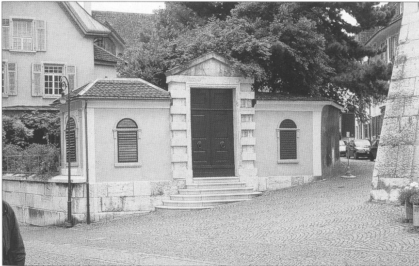
Abb. 8 ...und nach der Renovation von Pavillon und Hofmauer, 2000.
