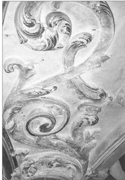
Abb. 2 Neubarocke Stuckaturen: freigelegte Farbfassung während der Restaurierung.
