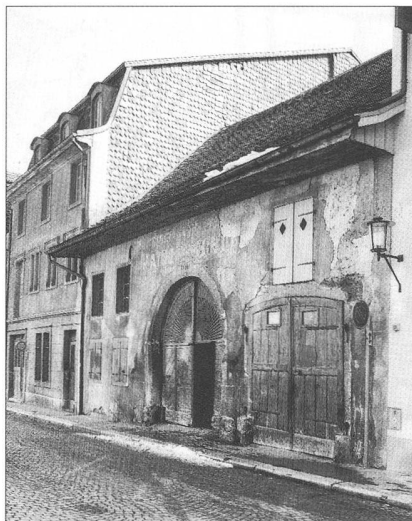
Abb. 1 Solothurn, Löwengasse 6. Scheune vor dem Umbau, 1991...
