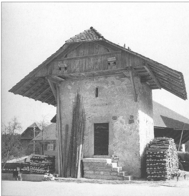
Abb. 2 ...nach dem Abbruch des Anbaus und der Errichtung einer neuen Zugangstreppe, im März 1961...
