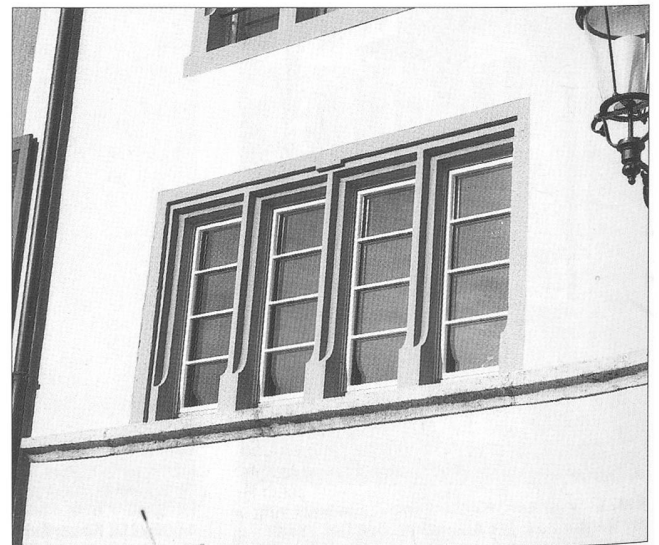
Abb. 7 Reihenfenster im ersten Obergeschoss, Zustand nach der Rekonstruktion.
