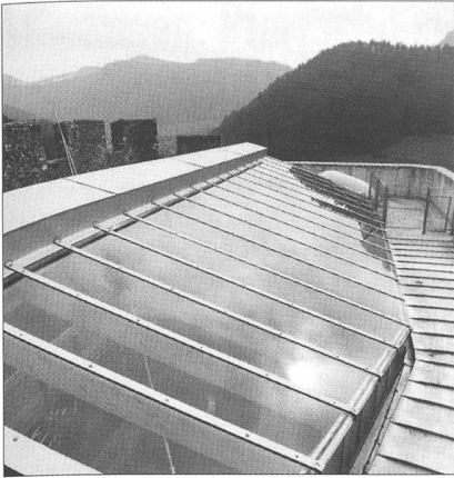
Abb. 4 Glasdach zum Schutz des Innenraums.
