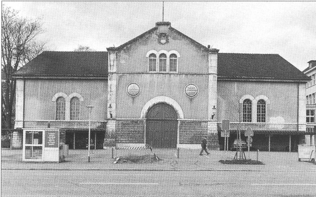
Abb. 1 Solothurn, Reithalle von 1863, vor der Renovation, im März 2001...
