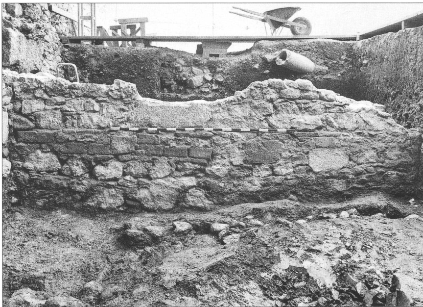
Abb. 15 Nordfassade Bau VIII, unter dem Meterstab, der auf einem leichten Mauerabsatz liegt, sind deutlich grossformatige Backsteine zu erkennen.
