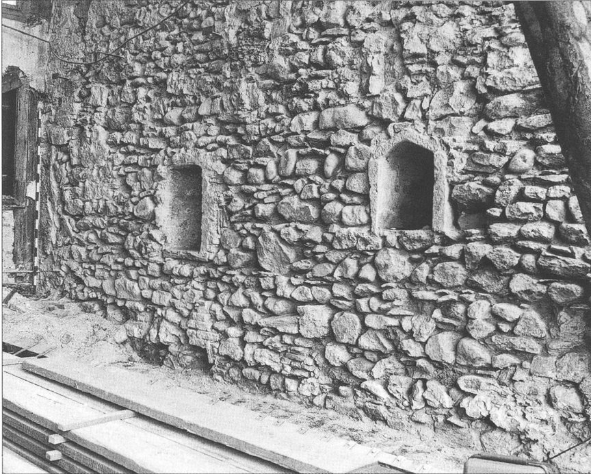
Abb. 14 Brandmauer Ost, nach der Freilegung im Rahmen der Bauuntersuchungen von 1998. Im unteren Teil die stark brandgeschädigte Wand von Bau IV, darüber Mauerwerk von Bau V mit unregelmässiger Abbruchkronen auf die der Giebel zur Scheune von 1588 aufgesetzt ist.
