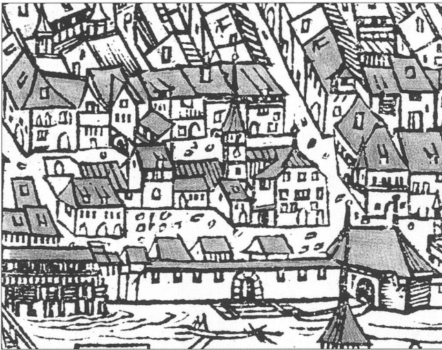
Abb. 12 a Ausschnitt aus dem Stadtprospekt in der Chronik von Stumpf, 1548. Der Häuserblock zwischen Löwengasse und Landhausquai im Zustand von 1546. Gut erkennbar der alte Hafenplatz und das Tor zur Schiffflände mit Anlegefloss sowie in der Mitte der Häuserzeile am Platz das auffallende Gebäude, das im Kern aus der Bauphase VIII bestehen haben könnte.
