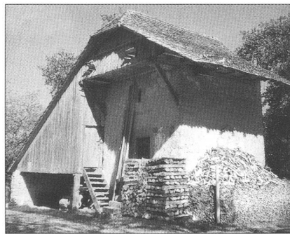
Abb. 1 Eppenberg-Wösch nau, Speicher Nr. 14, mit Wagenunterstand und Holzhaus, im Mai 1950...
