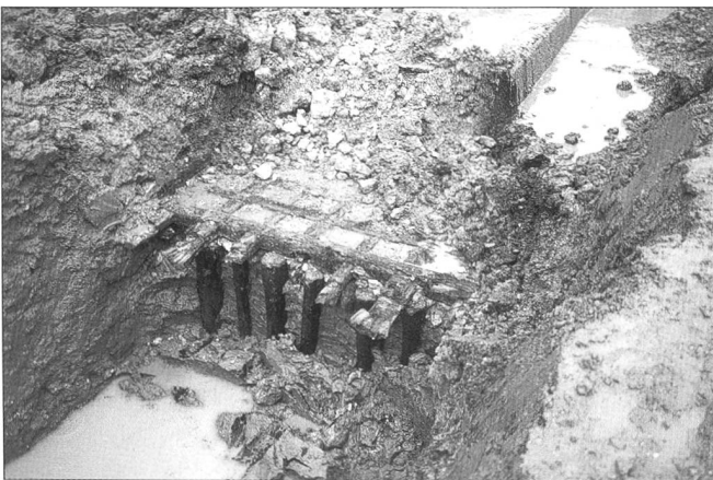
Abb. 43 Solothurn/Dornacherplatz. Balkenrost und Pfählig unter der Schanzenmauer in Etappe 2. Von Südosten.
