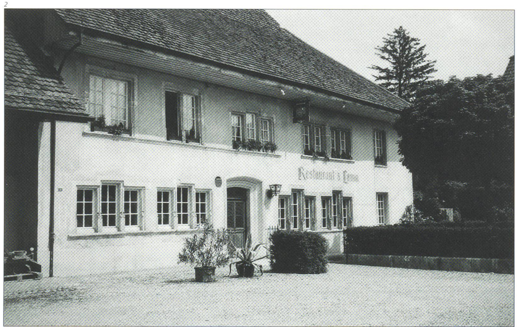
Abb. 2 Gasthaus «Zum Lamm», Zustand vor der Restaurierung.
