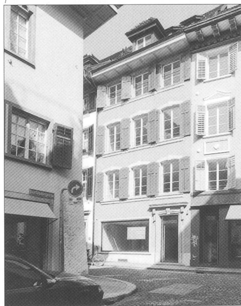
Abb. 1 Barfüssergasse 11 und 13, Zustand nach der Renovation 2006.
