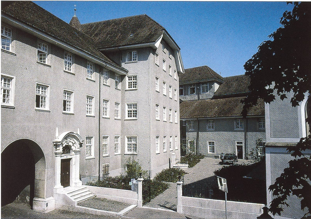
Abb. 12 Das 1665/66 errichtete neue Konventgebäude des ehe- maligen Klosters, heute «Franziskanerhof» genannt. Zustand 2006.
