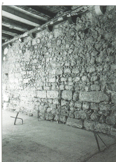
Abb. 3 Schrägsicht des nahezu unbefensterten Abschnitts der ersten Erweiterung. Wo das Mauerwerk nicht durch jüngere Eingriffe gestört ist, zeichnen sich deutliche horizontale Schichten ab.
