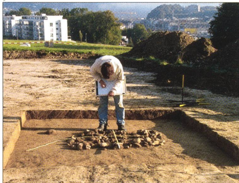
Abb. 7 Oberbuchsiten / Bachmatt. Freilegen der langen Ost-West-Mauer unter dem Parkplatz nördlich des Gemeindehauses.
