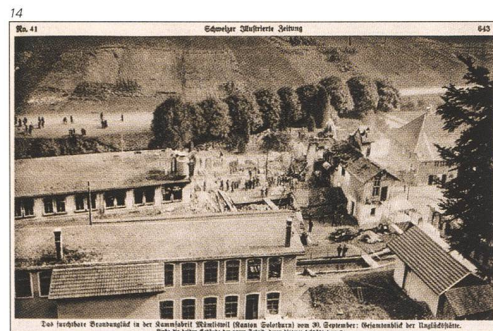
Abb. 14 Von der Wucht der Explosion wurde am 30. September 1915 der Haupttrakt der Kammfabrik komplett zerstört. Der Trakt am Waldrand und das Turbinenhaus (beide im Vordergrund) sind bis heute erhalten geblieben.
