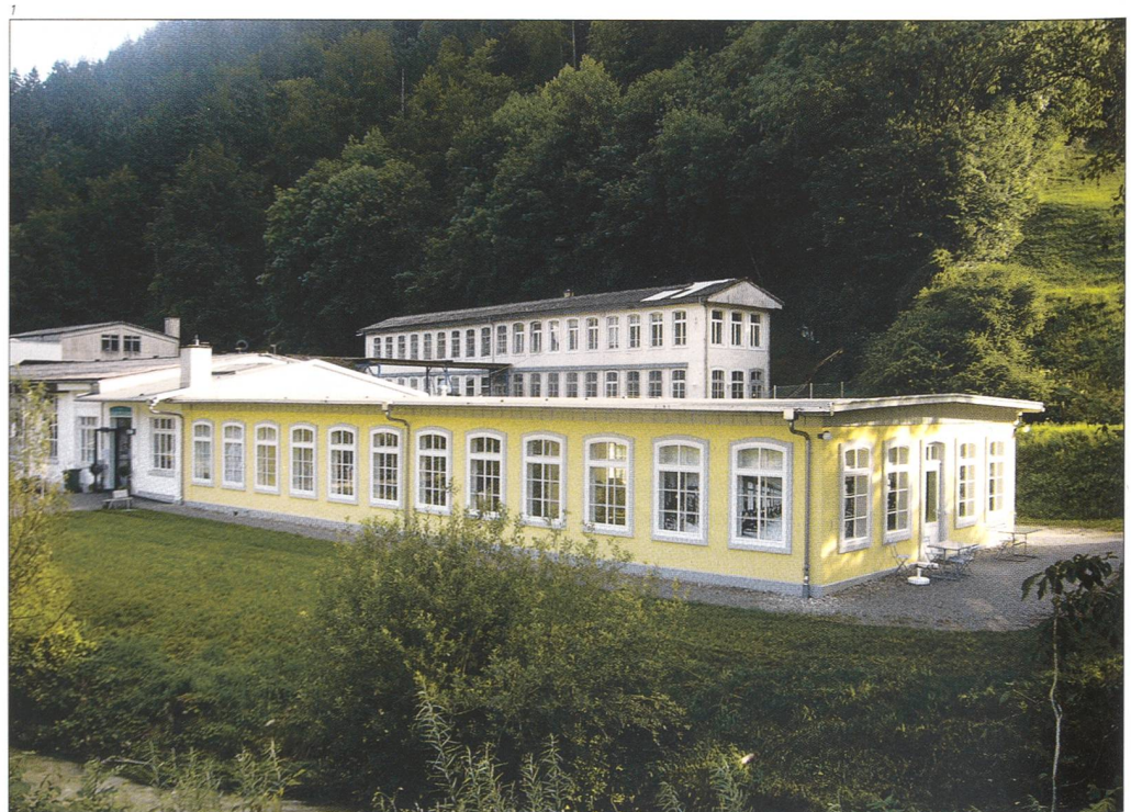
Abb. 1 Mümliswil, Museum HAARUNDKAMM. Ansicht nach der Restaurierung 2007. Das Museum ist heute ein kultureller Magnet im Naturpark Thal.
