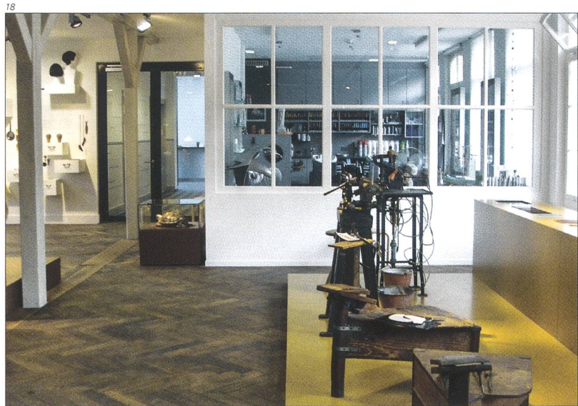
Abb. 18 Wo früher der Kontor stand, empfängt ein moderner Coiffeursalon seine Kundschaft. Im Ausstellungssaal wurde der Eichenparkettboden belassen und aufgefrischt, bei den Dachstützen die fehlenden Büge nach altem Vorbild wieder eingesetzt.
