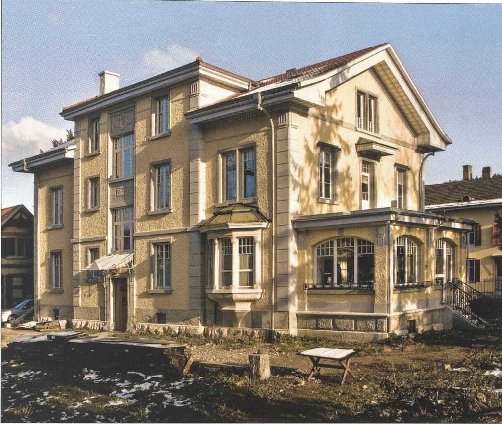
Abb. 12 Blick vom Garten zur restaurierten Villa.
