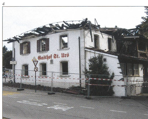
Abb. 4 Biberist, Gasthof «St. Urs». Zustand nach dem Brand von 2008.
