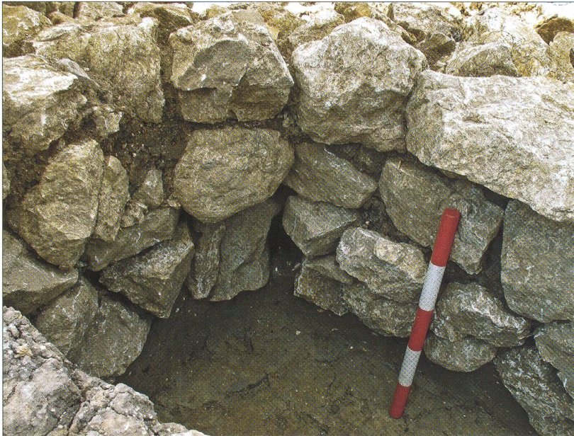
Abb. 11 In der Ecke von M2 und M3 (links) waren rostrote Jurakalksteine verbaut. Die Anschlussmauer M7 (rechts) enthält praktisch keine verfärbten Steine.
