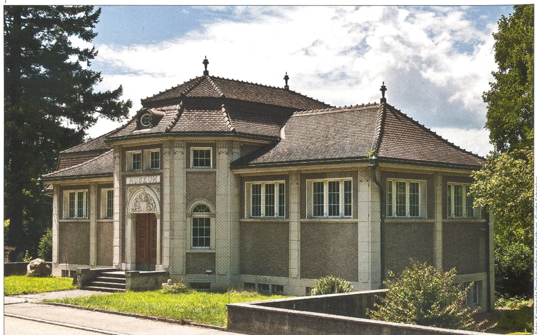
Abb. 1 Schönenwerd, Oltnerstrasse 80, Schweizerisches Zündholz- museum. Die Aufnahme zeigt den Bau von 1909 von Nord- osten. Foto vor der Restau- rierung 2010.
