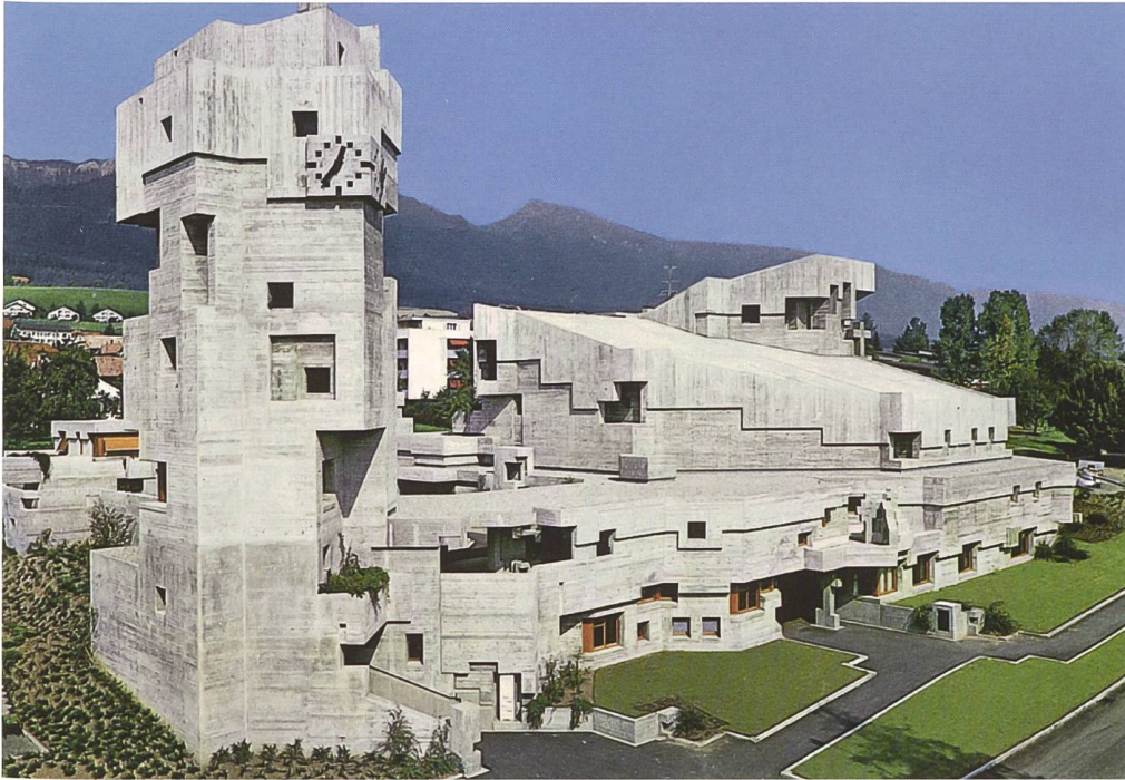
Abb. 11 Die Klemenzkirche von Südwesten in einer Aufnahme um 1970, vor der Dachsanierung des Kirchenschiffs.
