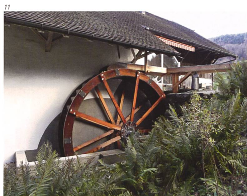
Abb. 11 Welschenrohr, Mühle 69, Lochmühle. Das 2013 neu errichtete Wasserrad.
