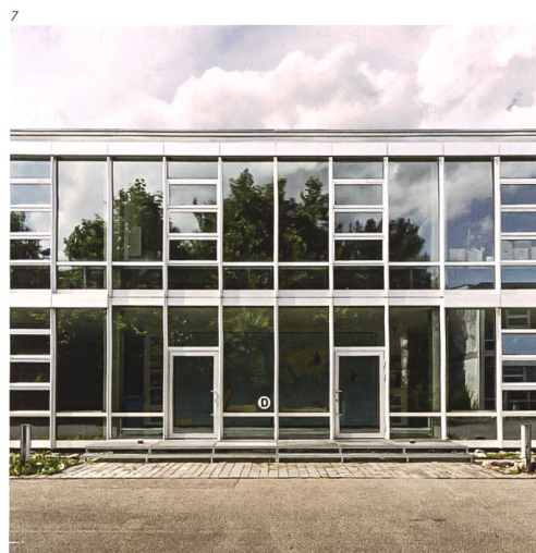
Kant. Denkmalpflege, Guido Schenker
