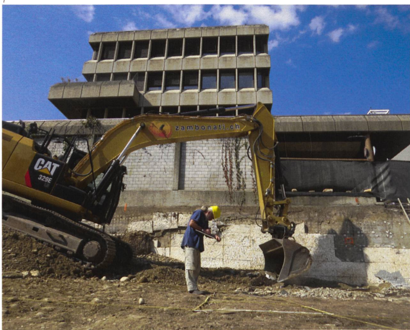
Abb. 1 Baubegleitung im September 2015 an der Römerstrasse 3 und 5.
