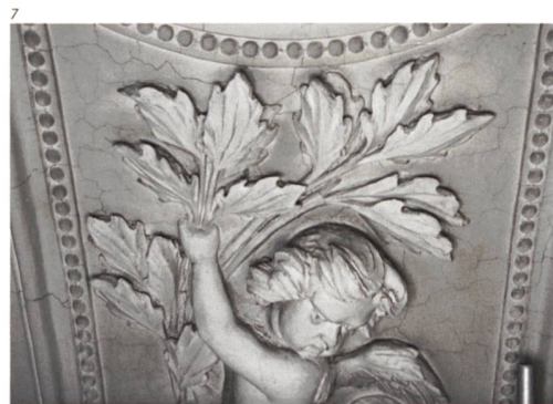
Abb. 8 Detail der Stuckaturen während der Restaurierung. Die Sanierung von Hohlstellen erfolgte mittels konisch geöffneter Bohrlöcher, in die Mörtelproppen als Verankerungen eingesetzt wurden.
