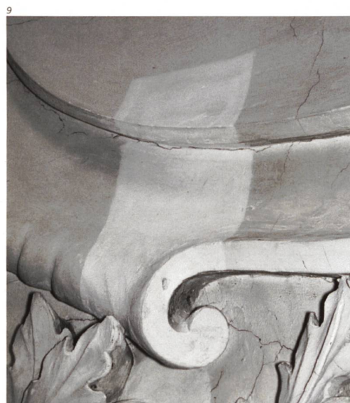
Abb. 10 Die Sanierung von statischen Rissen im Gewölbereich erfolgte durch das Verfüllen mit feinem Grundputz, der nach kurzem Antrocknen abgeglättet wurde.
