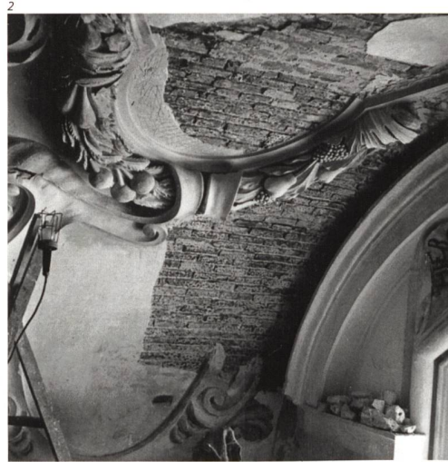
Abb. 2 Detail des Gewölbereichs während der Restaurierung 1952/53. Teilweise mussten grössere Partien neu verputzt und stuckiert werden. Gut sichtbar ist auch das Backsteingewölbe als Träger der Stuckaturen.
