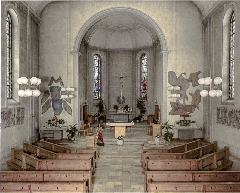
Abb. 14 und 15 Die Kirche vor der Restaurierung 2015/16. Gut sichtbar sind die starken Verschmutzungen an Aussenwänden und Gewölbe.
