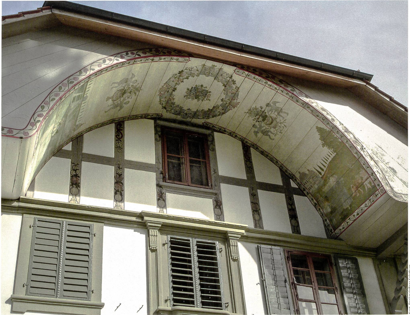
Abb. 8 Untersicht der Ründe mit dekorativen Malereien nach der Restaurierung. Foto 2017.
