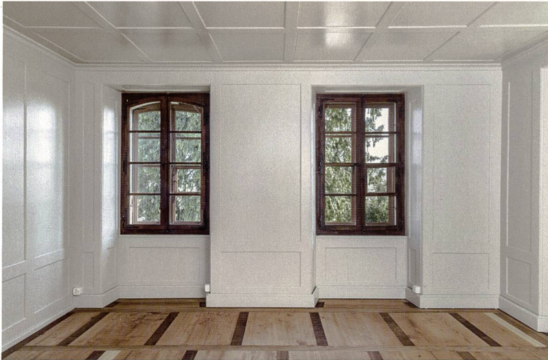
Abb. 18 Stube im Erdgeschoss, Blick gegen Süden mit den restaurierten einfachverglasteten Fenstern aus Eiche mit Vorfenstern. Foto 2016.
