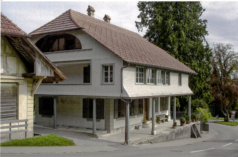
Abb. 9 Ansicht von Norden mit der umlaufenden, mit Holz- schindeln verkleideten Laube. Foto 2017.
