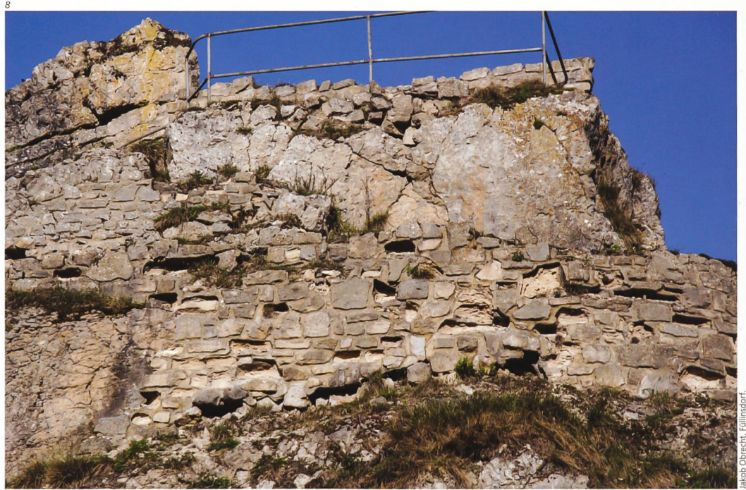
Abb. 10 «Hoher Felsen», 2017, von Süd- westen. Arbeitsgerüst. Im Vor- dergrund der Werkzeugcontai- ner und das Materialdepot der Freien Bauhütte GmbH, Basel.
