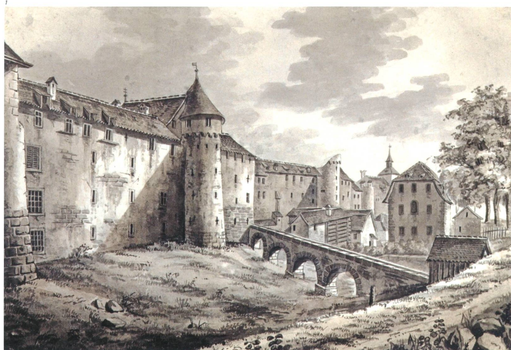
Abb. 1 Solothurn, Blick gegen die nördliche Stadtmauer: In der Bildmitte der innere Aquädukt des Stadtbachs, der zwischen dem Franziskanerkloster und der Gerberei in die Stadt geleitet wurde. Lavierte Sepiazeichnung von Ludwig Schulthess, 1840.
