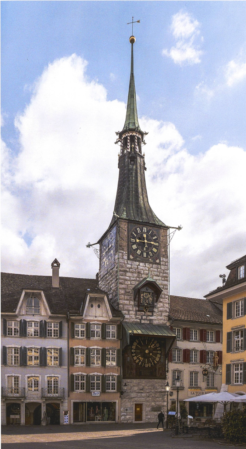
Abb. 2 Zeitglockenturm, Ansicht nach der Restaurierung 2022.
