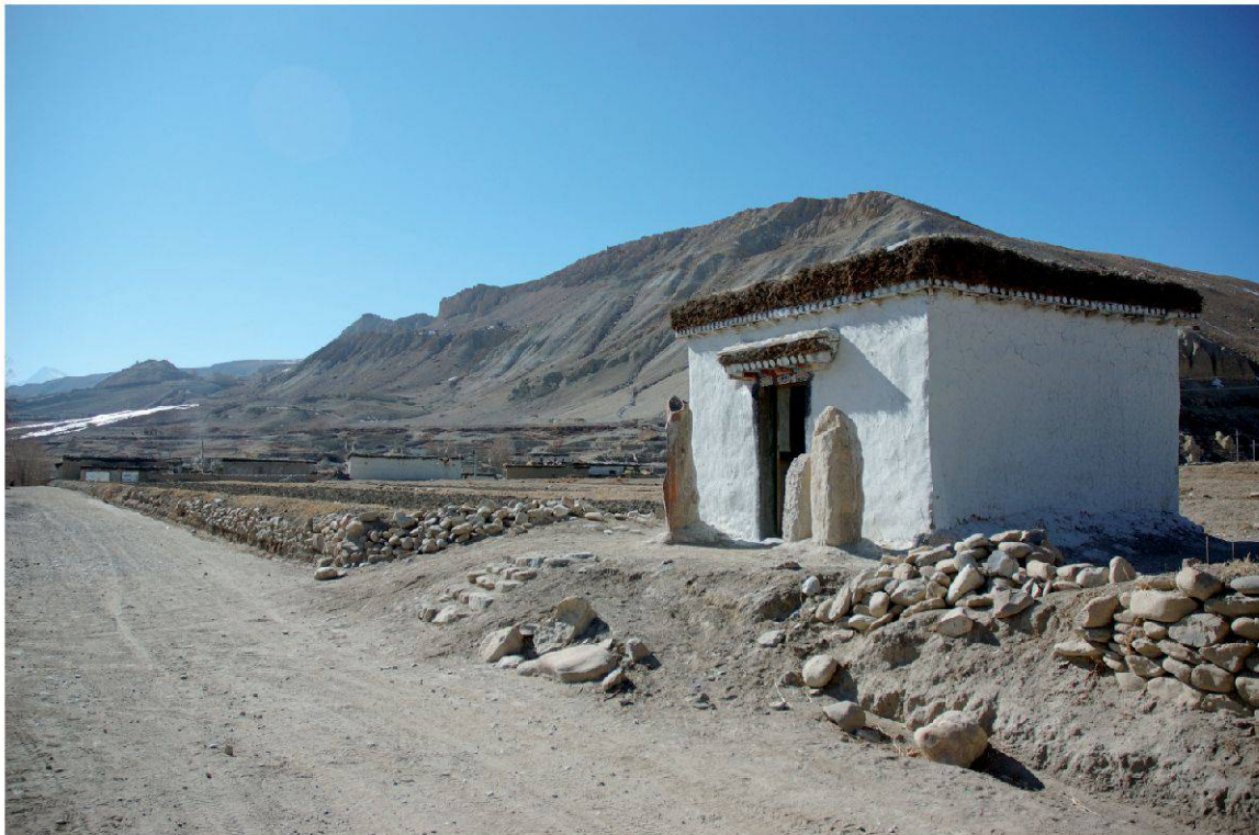
Abb. 1: ICog ro, Gemeinde Zhi sde, Kreis sPu rang, Westtibet: Gebäude mit der Avalokiteśvara-Stele und einigen abgewitterten Steinstelen davor (Foto: Ch. Papa-Kalantari, 2007).
