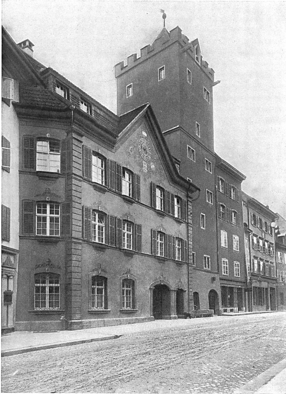
Façade sur la rue du Marché
