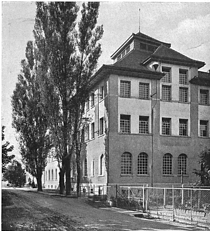
:: Weideli et Kressibuch, architectes B. S. A., Kreuzlingen :: Vue partielle de la fabrique de savon Schuler à Kreuzlingen
