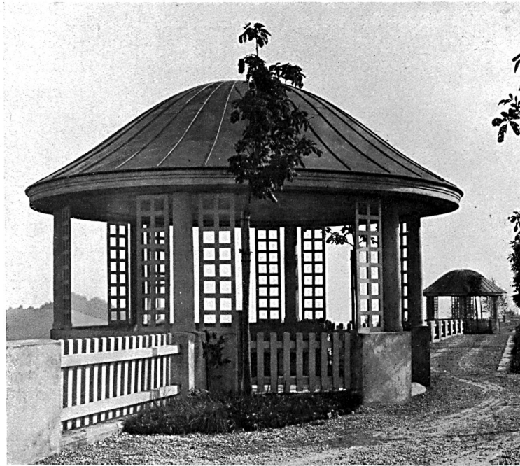
Pavillon sur le mur d'enceinte du cimetière de Hérissau.
