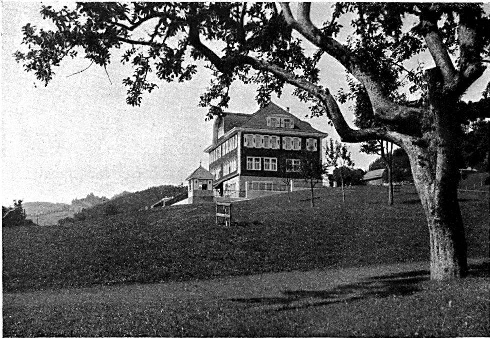
Vue de la façade à l'est.
