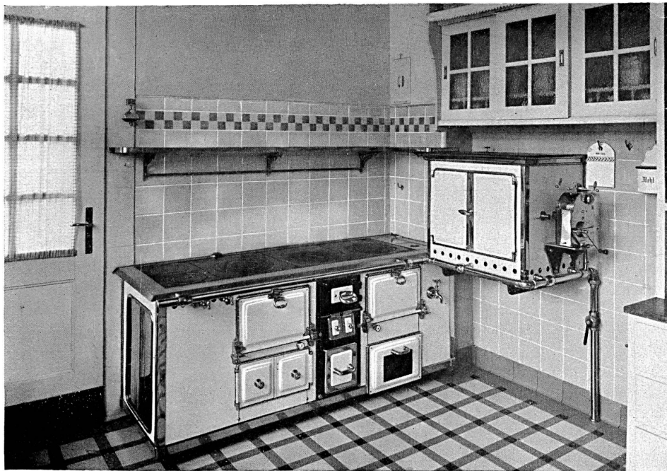
La cuisine dans la villa Hoffmann à Wollishofen. Fourneau à gaz et charbon « Senking » combiné avec appareil à grill et broche.
