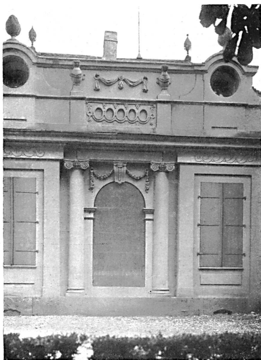
Partie centrale de l'un des pavillons latéraux.
