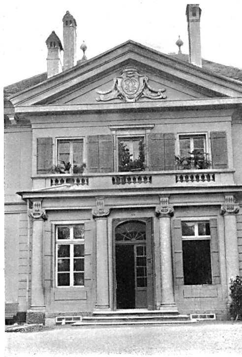
Partie centrale du corps principal.
