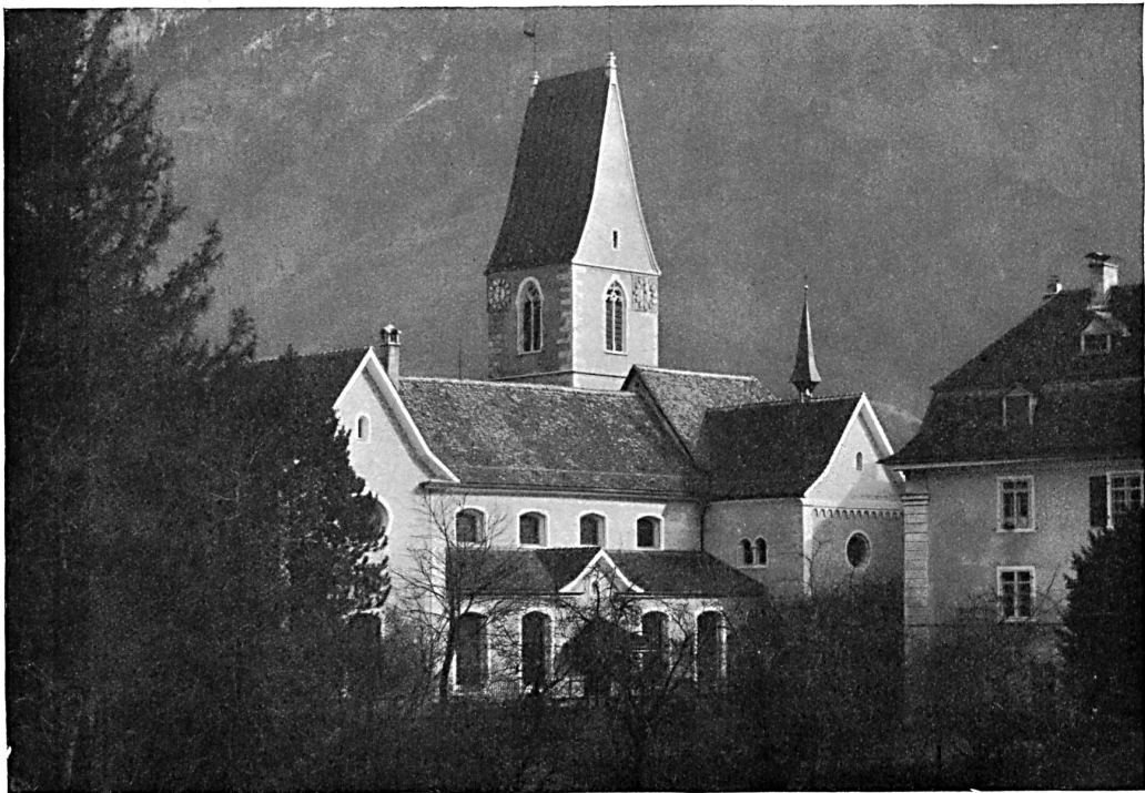
La reconstruction de l'église de Schänis (St-Gall). Architecte: Adolphe Gaudy à Rorschach.
