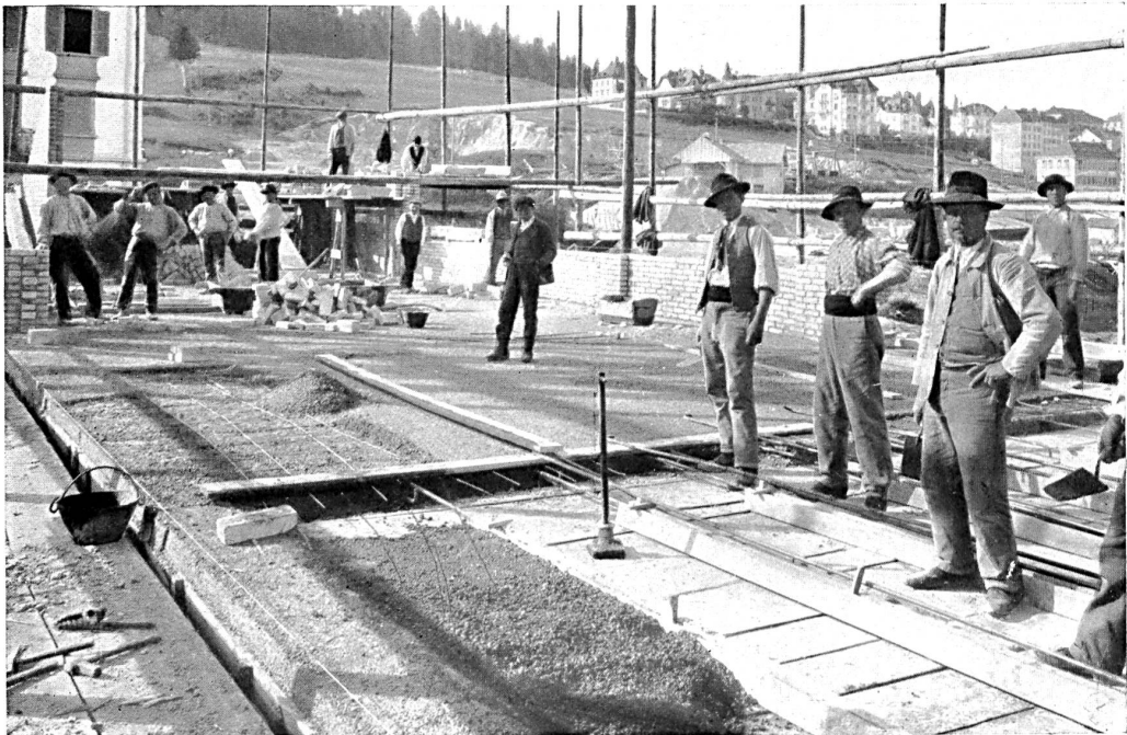
Construction des planchers.
