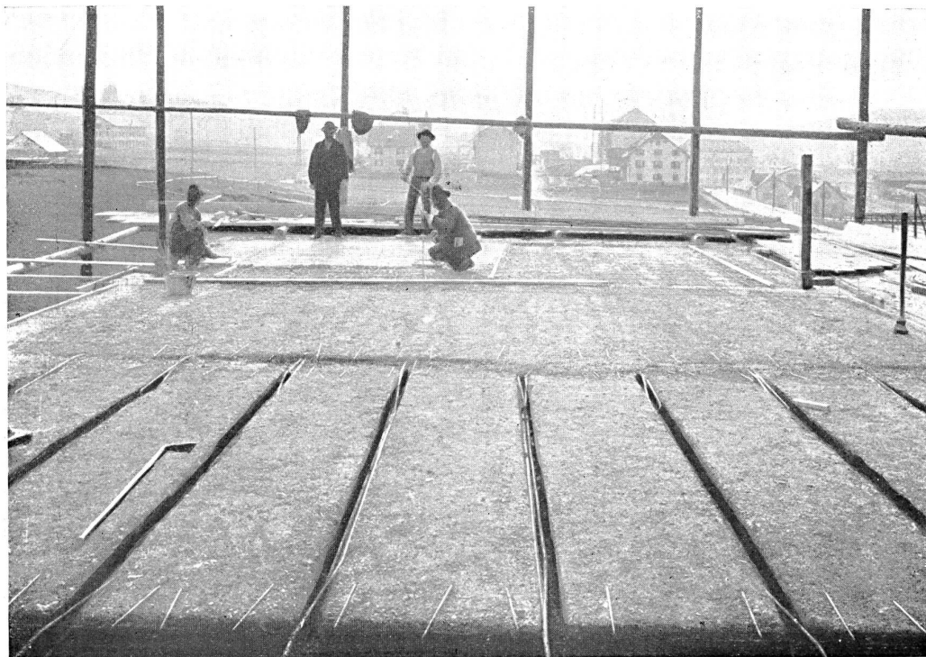
Le béton armé dans la construction d'immeubles industriels. Après le remplissage. Diverses phases de la construction des planchers d'une fabrique.
