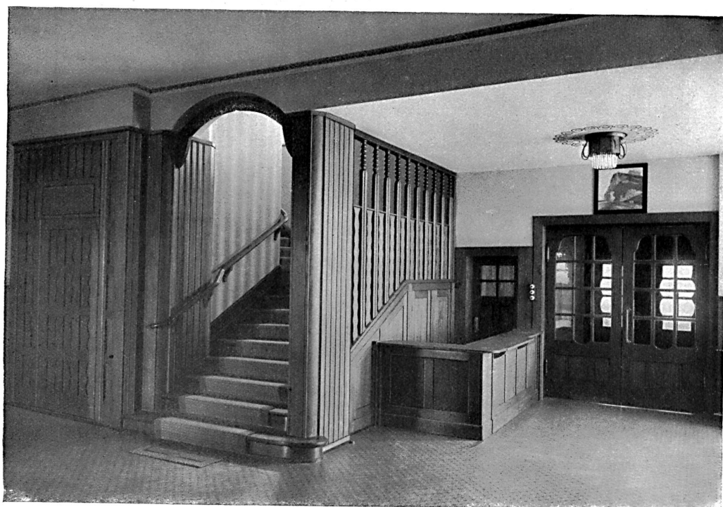
Vestibule d'entrée en sapin teinté en jaune clair. L'établissement climatérique de «Sonn-Matt» près de Lucerne. — Architectes: Theiler & Helber, Lucerne.
