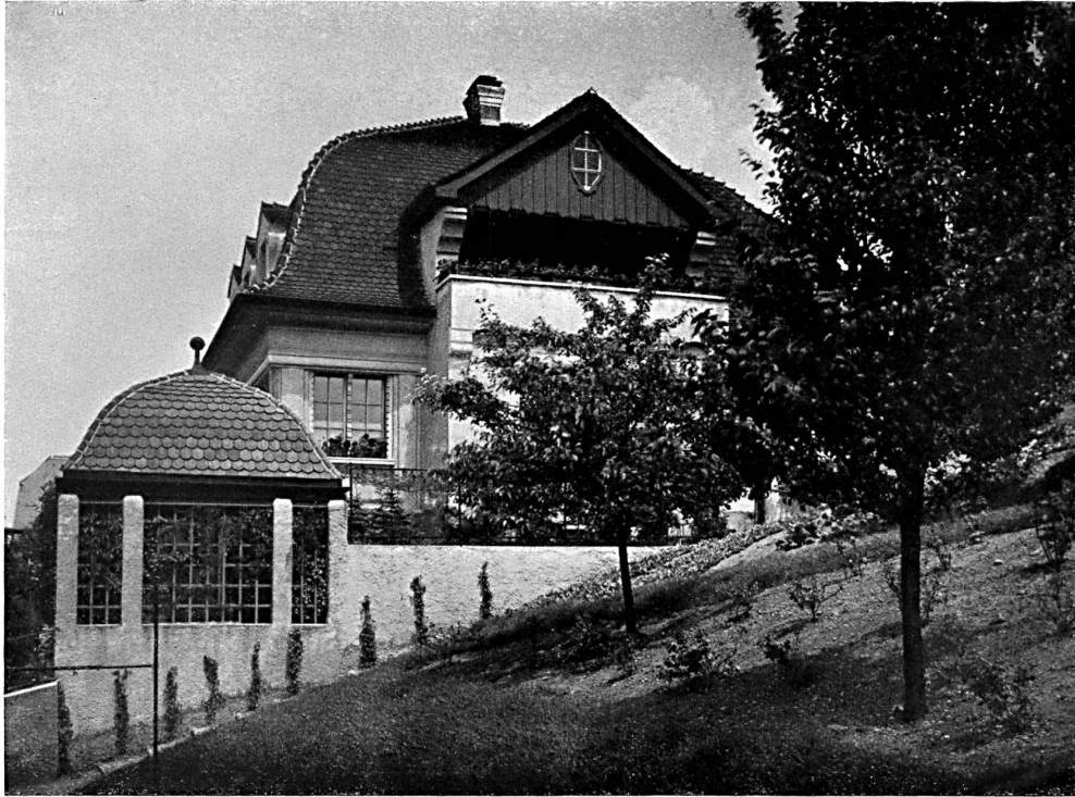
Maison d'habitation du Prof. Dr Wreschner à Zurich, Goldauerstrasse. — Plans et façades page 92.
