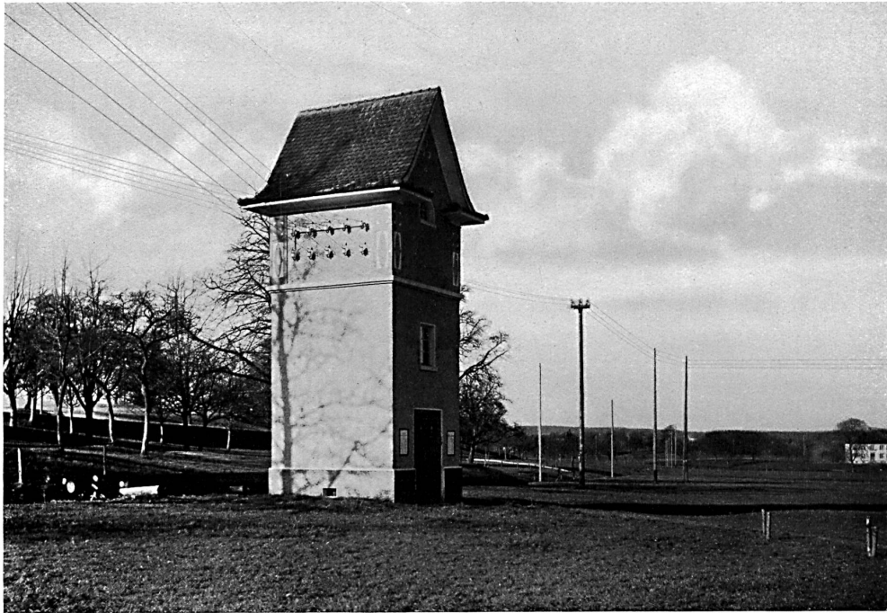
Transformateur près de Waldkirch (St-Gall). Exécuté par le service cantonal des bâtiments.
