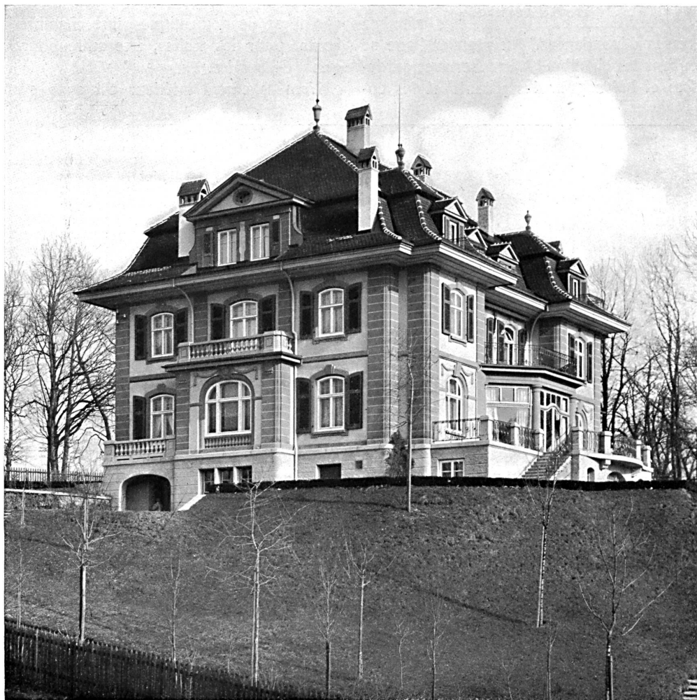
Villa du Dr. E. M. à Berne. — Façades sud et ouest. — Architecte: Albert Gerster, Berne.
