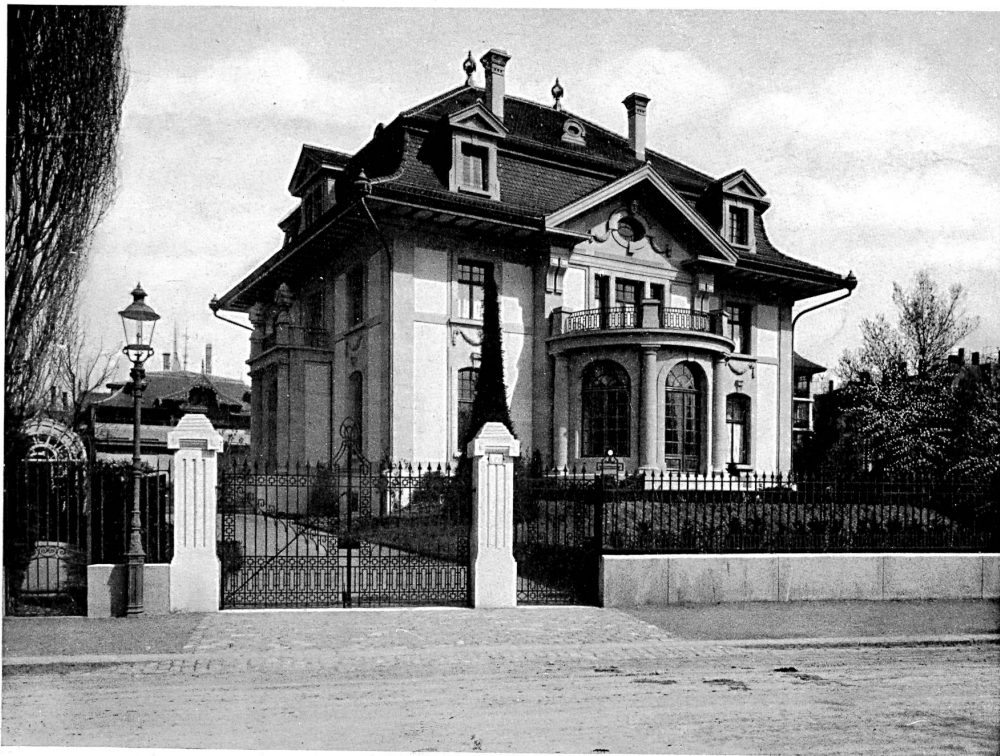
Villa F. Ernst à Zurich. — Façade principale. — Architecte : Otto Honegger à Zurich.
