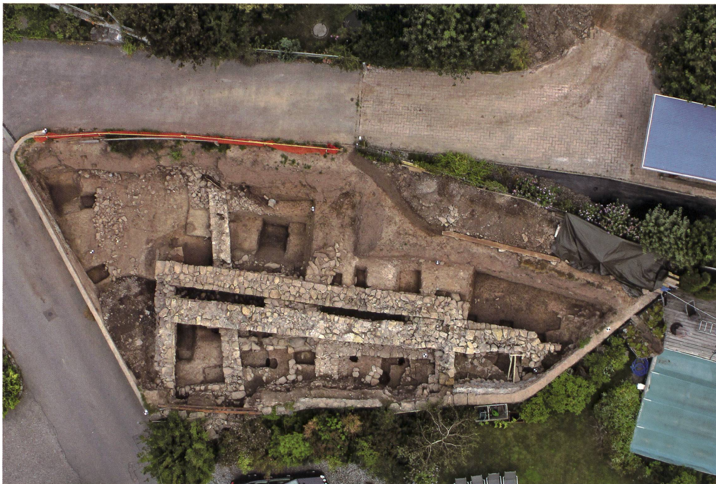
Fig. 1 Vue aérienne du chantier (photo Vision-Air, Cyril Neri).
