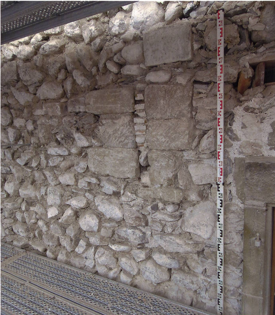
Fig. 5 ECHICHENS – Château. Meurtrière dans la façade nord. La portion de mur située à droite et au-dessus des vestiges du jour défensif appartient à une intervention postérieure en relation avec les fenêtres existantes (photo Archéologie cantonale, Lausanne, V. Chaudet).
