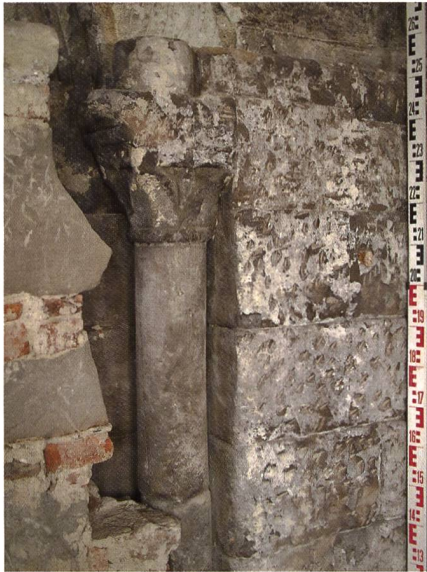
Fig. 14 LAUSANNE – Parlement Est. Baie romane en cours de dégagement : détail du piédroit nord avec sa colonnette, son chapiteau et la naissance de l'archivolte (photo Archéologie cantonale, Lausanne, V. Chaudet).
