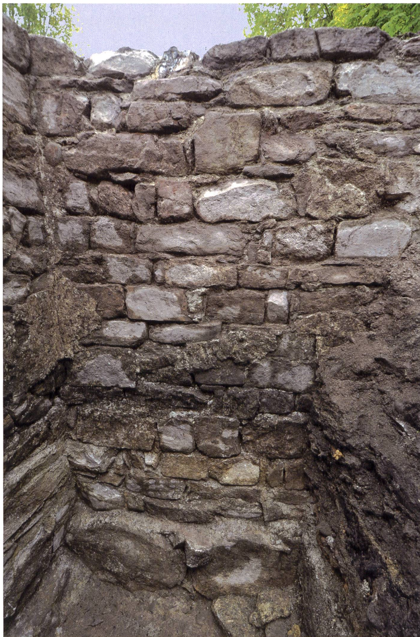
Fig. 16 LA TOUR-DE-PEILZ – Musée du Jeu. Élévation interne de l'angle ouest du donjon; le revêtement partiellement conservé appartient à un réaménagement (© Archéotech SA).
