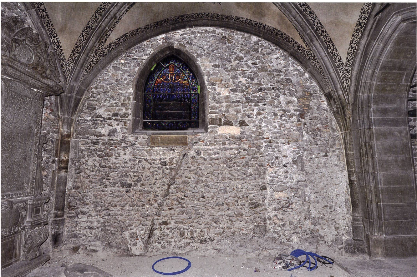
Fig. 32 NYON – Temple de Nyon. Paroi intérieure nord de la chapelle CN1 avec le ravalement et la surélévation de l'étape IX (© Archéotech SA).
