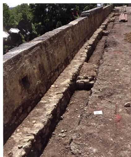
Fig 11 GRANDSON – Château. Vue ouest de la terrasse supérieure sud, avec l'alignement des cinq contreforts internes contre le mur de braie, arasé pour la pose du parapet (© Archéotech SA).
