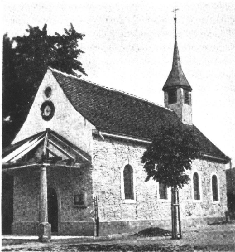
Die alte Kapelle von Freienwil beim Abbruch 1923
