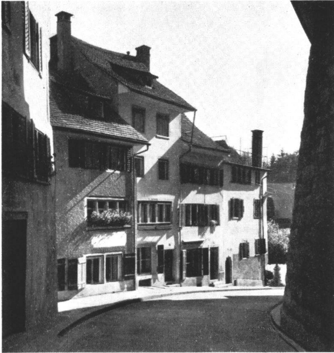
Im Rank in der Halde. Von links nach rechts: „zum roten Eck“. Dahinter der Gang zum Affenwagen oder zum Riesen. „Zum Schwert“ oder „zum Degen“ mit gut erhaltenen Fenstern im Erdgeschoss und im 1. Stockwerk „Zur Straussfeder“ mit nachträglich aufgebautem 3. Stockwerk. „Zum Weissen Kreuz“. An der Ecke der „Schlüssel“, an dem Terrassenaufbau und Kamin störend wirken. — Rechts die Kirchhofmauer.
