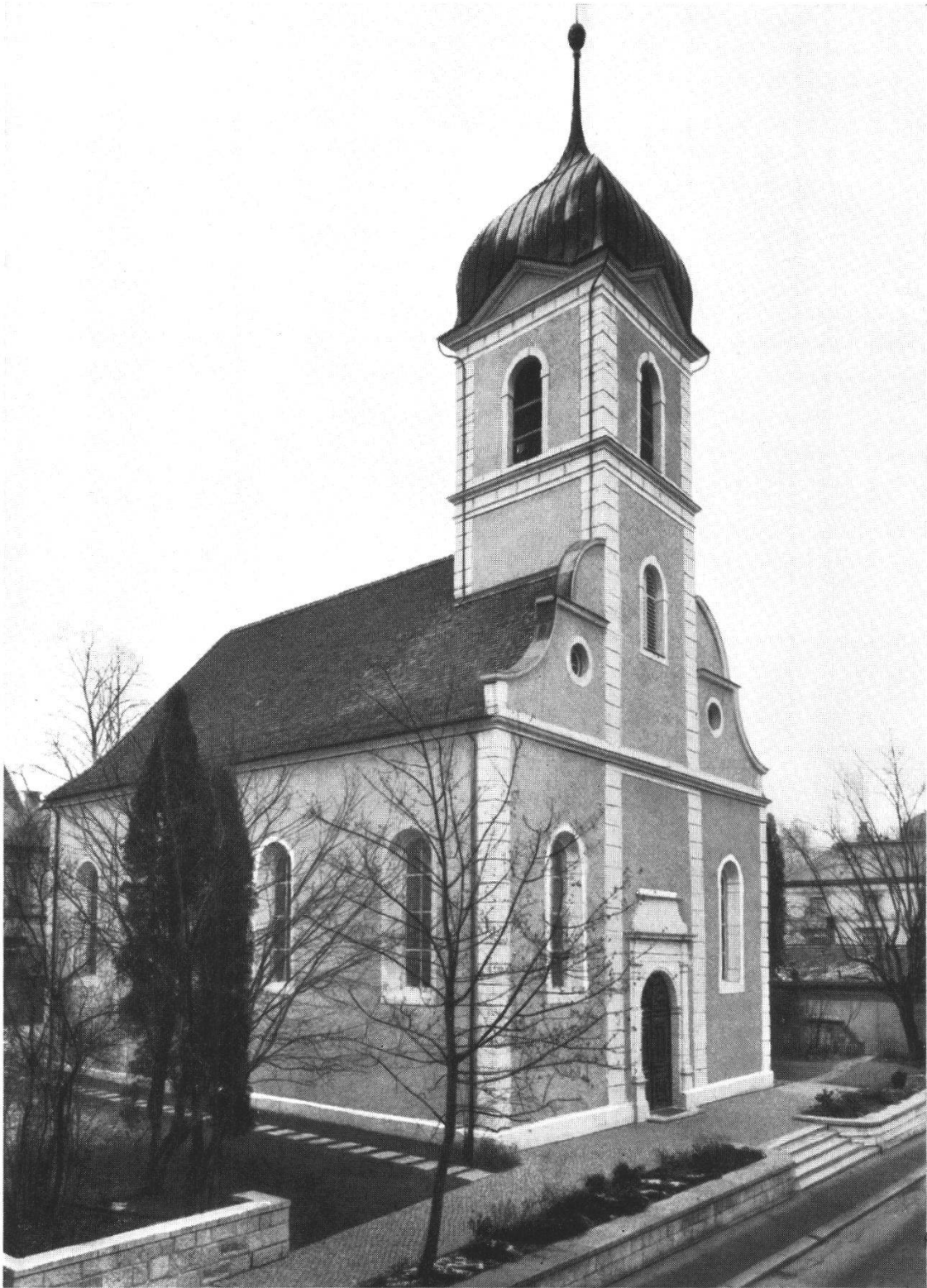
Baden. Reformierte Kirche. Ansicht von Süden. Der Turm wurde ursprünglich mit Blech beschlagen, da Schindeln zu gering, Kupfer zu teuer und Blei zu schwer gewesen wäre,
