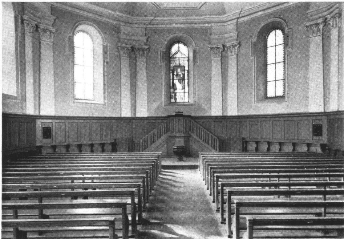
Innenraum vor der Renovation
