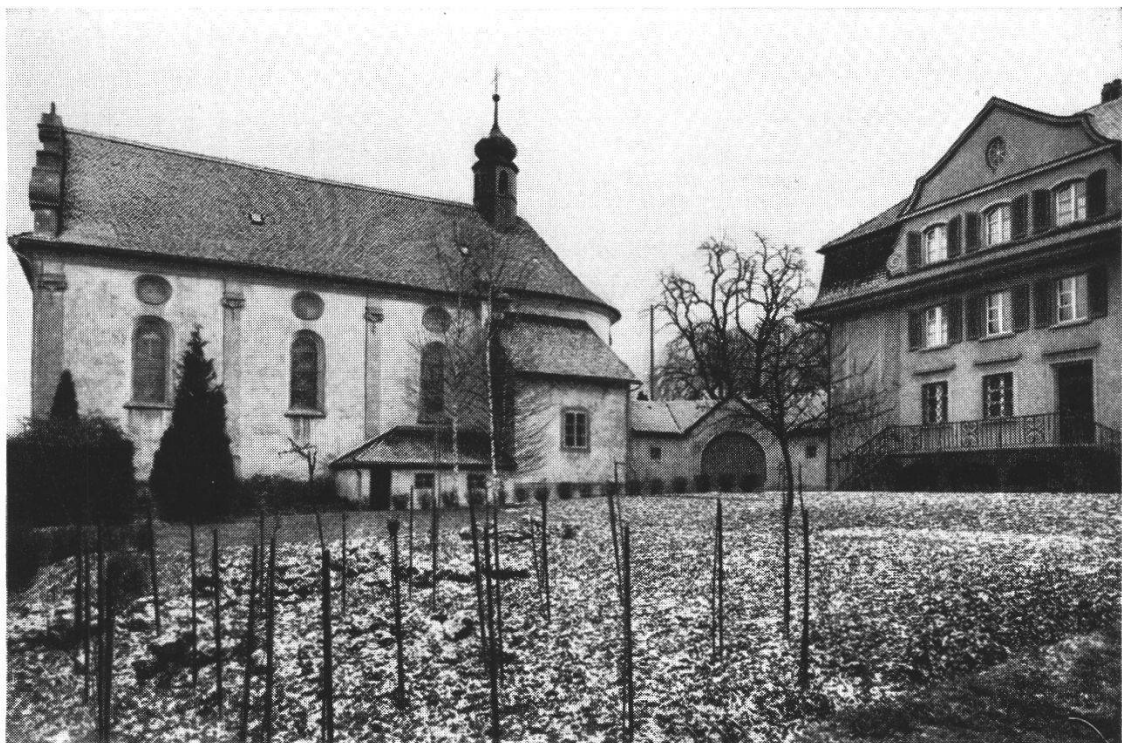
Westansicht vor der Restauration
