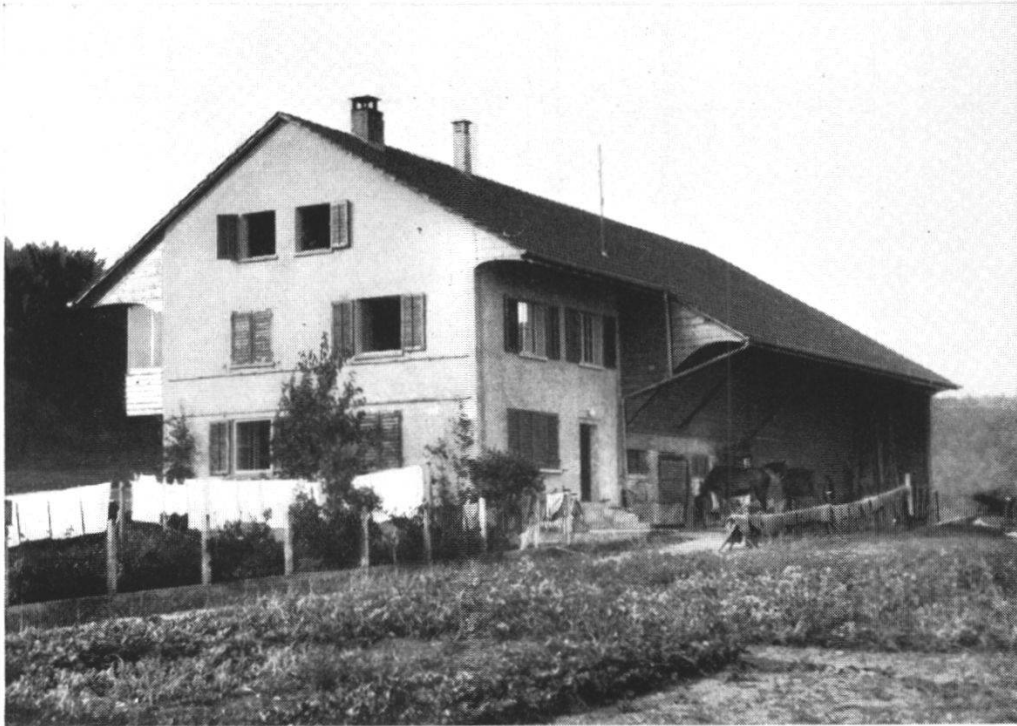
Siedlung H. Killer, Gebenstorf. Südostansicht.
