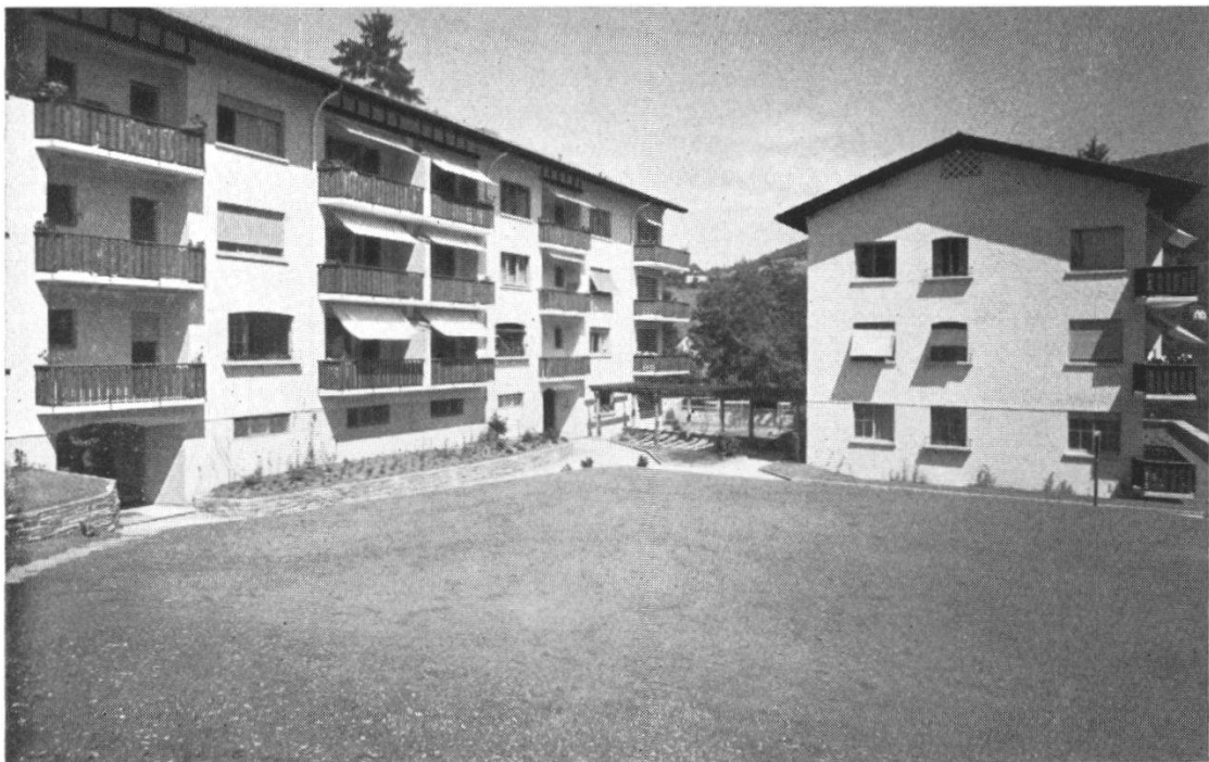
Brown Boveri Angestelltenhäuser an der Römerstraße Baden. 2 Reihenhäuser mit 25 Wohnungen zu 2, 3 und 4 Zimmer. Ölheizung, Warmwasser von zentraler Stelle aus, elektrische Küche mit Kühlschrank.
