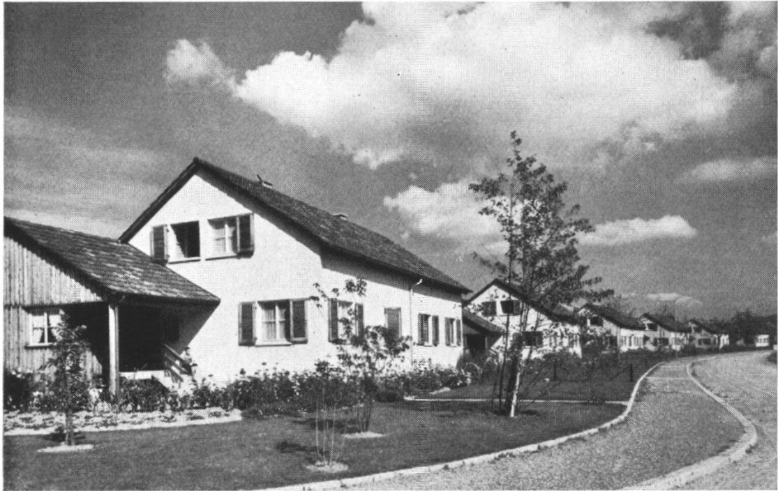
Brown Boveri Einfamilienhaussiedlung im «Klosterfeld» Wettingen. 49 Einfamilienhäuser zu 4, 5 und 6 Zimmer mit großem Garten.
