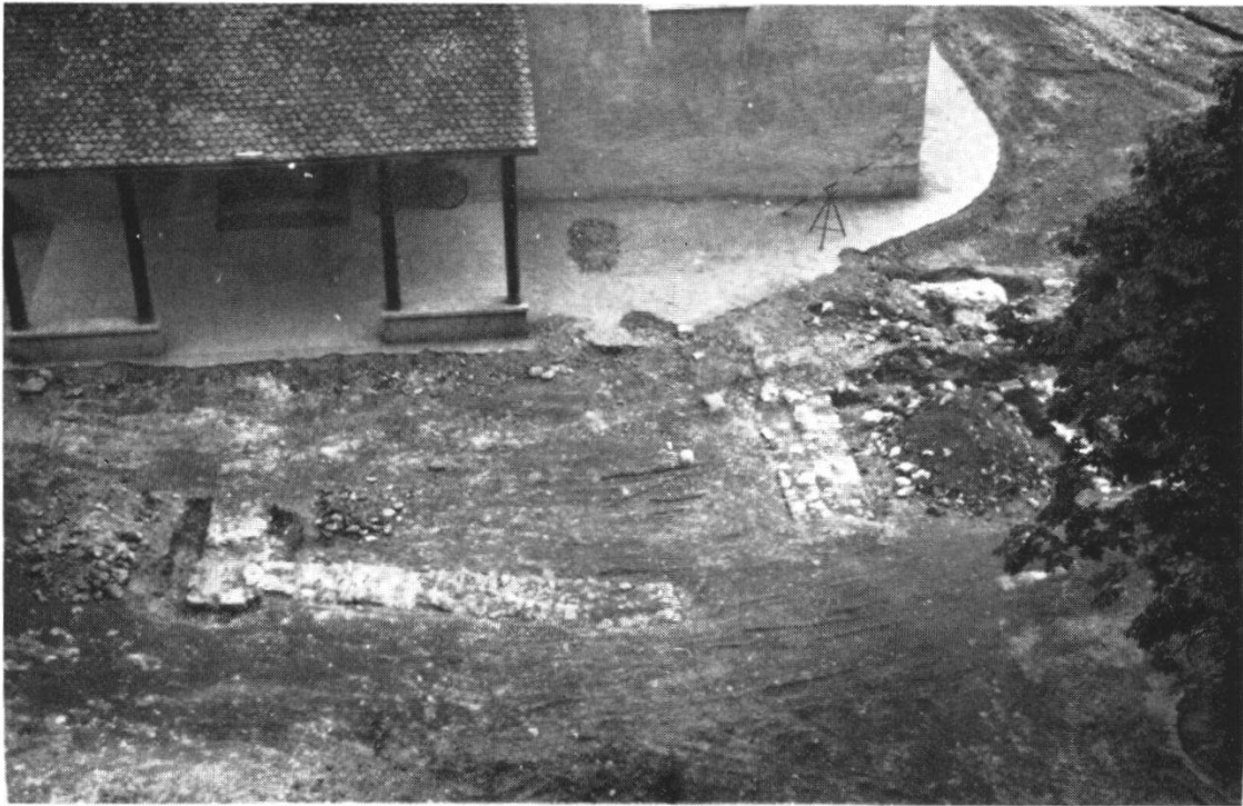
Abbildung 5. Blick vom Dach des Hauses «Zur Meerkatze» (Sieber-Kaufmann) gegen das Hauptportal der Kirche mit den Fundamenten des 1826 geschlossenen Hauses «Zum Schneggen».
