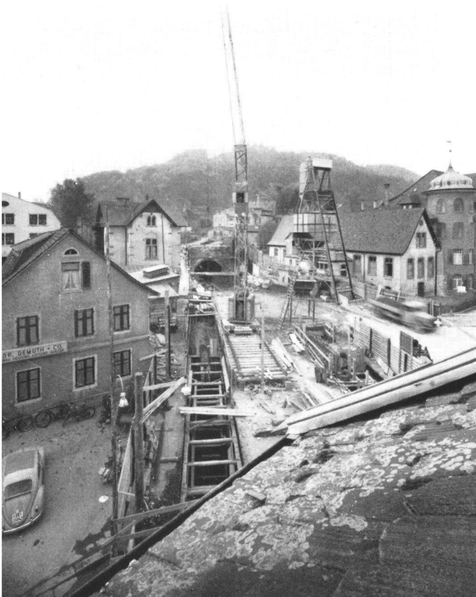
Bild 9 Mellingerstraße, offene Bauweis Erstellen der Tunnelseitenwände nach der Schlitzmethode
