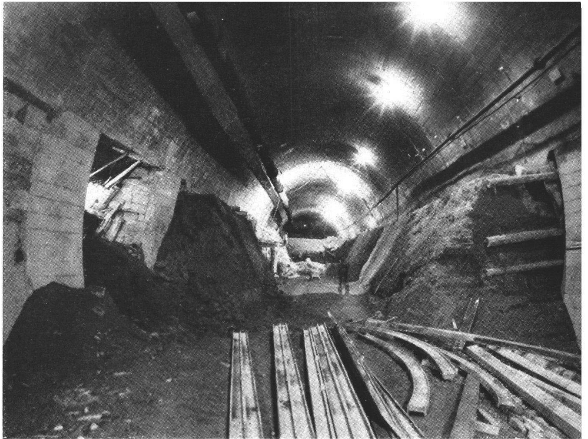
Bild 8 Kreuzlibergtunnel, letzte Ausbauphase in der Kies- und Moränenstrecke
