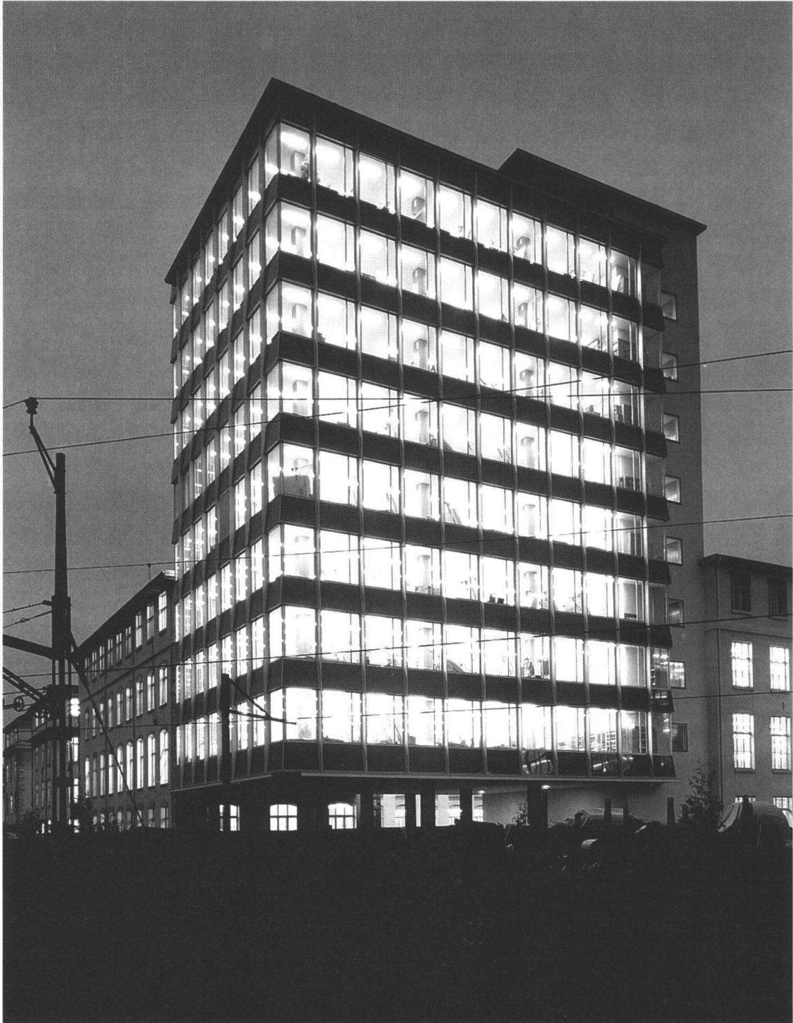
Der «Blaue Turm» von 1955/56 fügte sich in die Ecke eines grossen, um einen Hof errichteten Bürogebäudes, das 1898 begonnen und zuvor bereits mehrfach erweitert worden war (Bild 1956).
